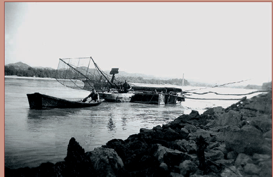
Fig. 32 Boudon (Bouches-du-Rhône). Placé en rive gauche le grand vire-vire de Raphaël Plo est en marche. Au premier plan le fort enracinement de la digue. Le très imposant panier de gauche de la roue de pêche sort de l'eau, et la pale (ou pale mate) qui suit, assure la rotation de la machine. En arrière-plan, la rive droite du Rhône, d'Arles. (Gard) et à droite, sur l'Arlesien, les piles du pont d'Arles, de type Seguin, privées de leur tourillon. Photos vers 1945-1950. Collection particulière
